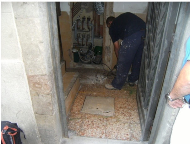
FOTO 3. Inici de les tasques d'excavació
