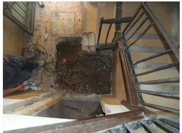
FOTO 4. Vista general un cop enretirat el paviment contemporani
